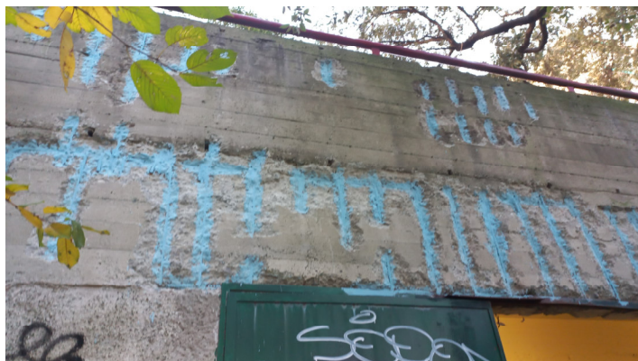
Passivazione armature
