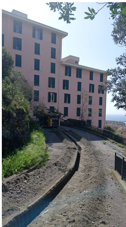
Scavo acque nere
