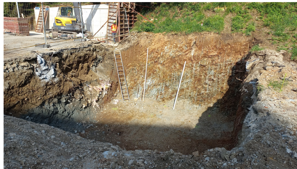
Scavo per vasche di laminazione
