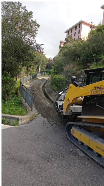
Scavo acque nere
