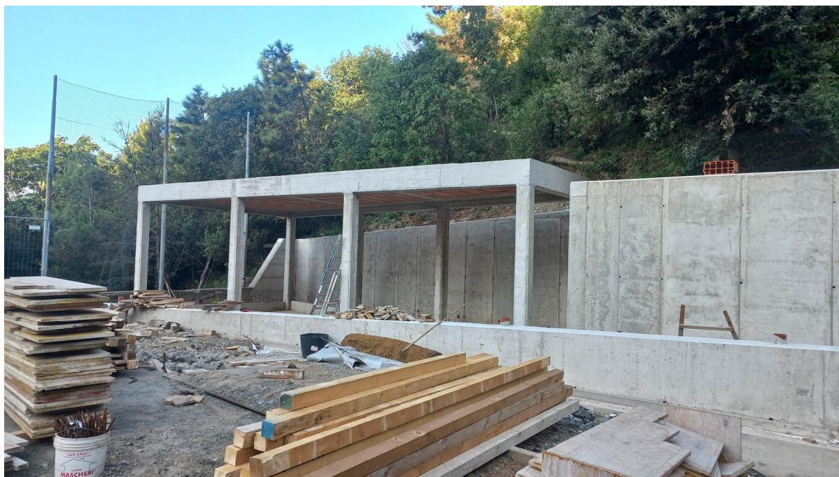
Locale spogliatoio e muri contenimento
