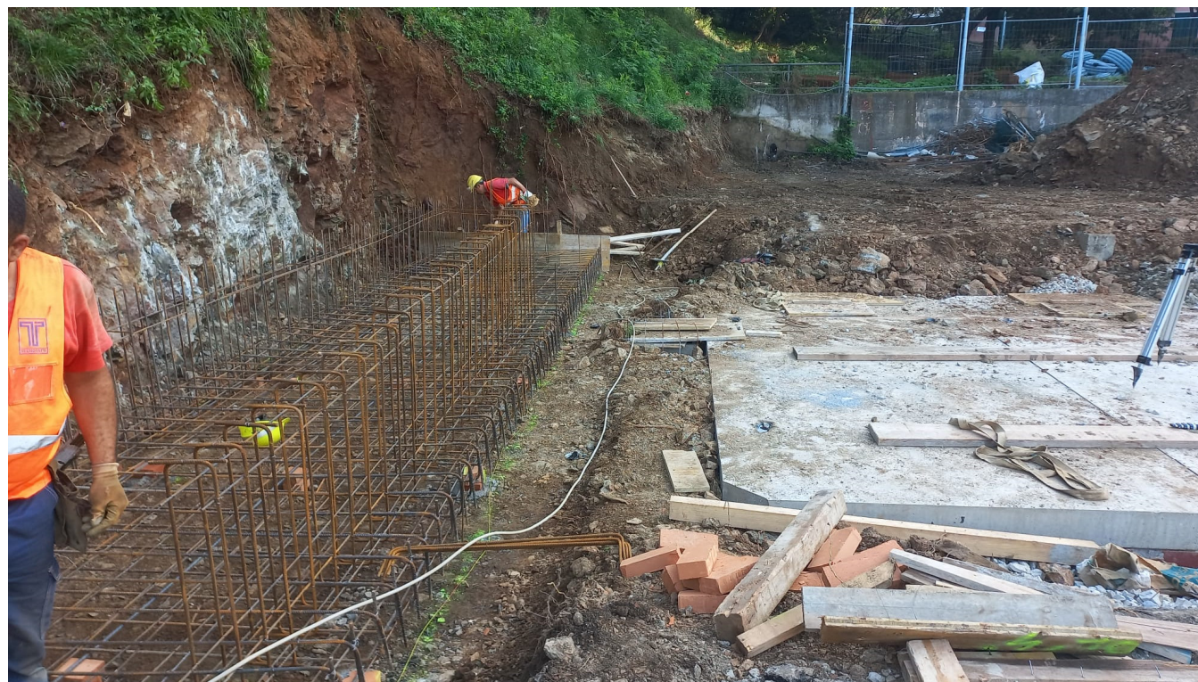
Scavi e orditure muri
