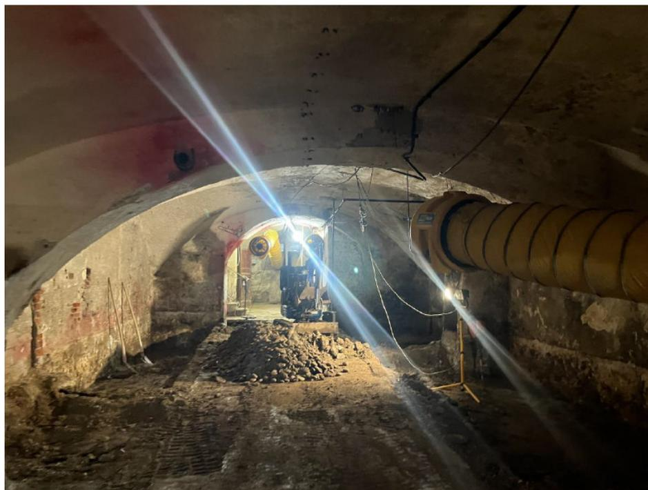
*Rimozione sottofondo piano interrato*
