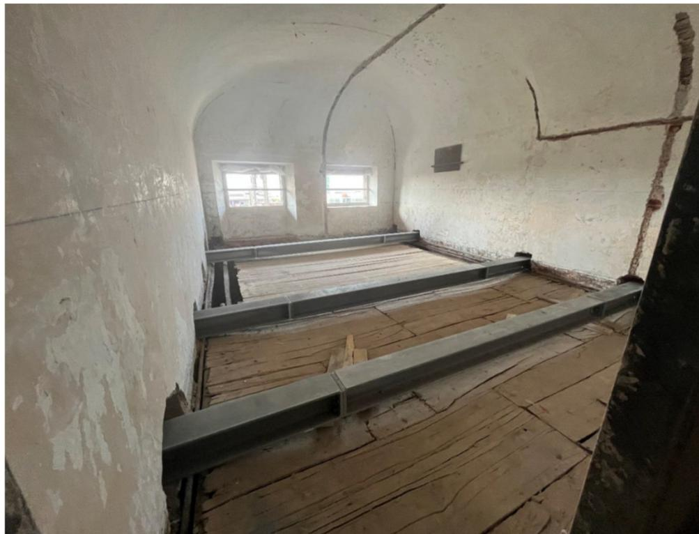
*Posa travi in acciaio nuovo solaio stanza C – P.2*
