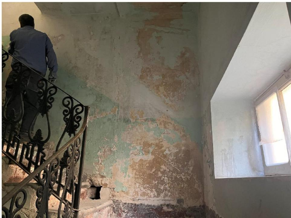
*Rimozione tinteggiatura vano scala P.2*
