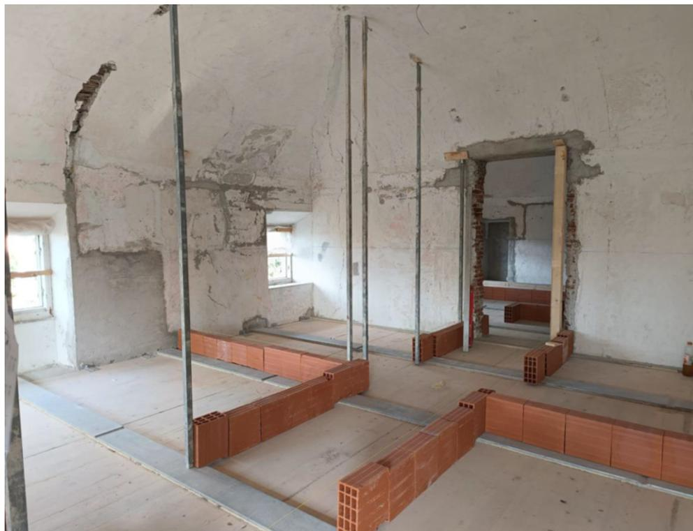
*Tracciamento delle tramezzature - P2*
