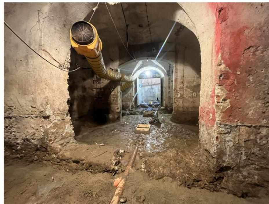
*Posa in opera Sistema di drenaggio acque, piano interrato*
