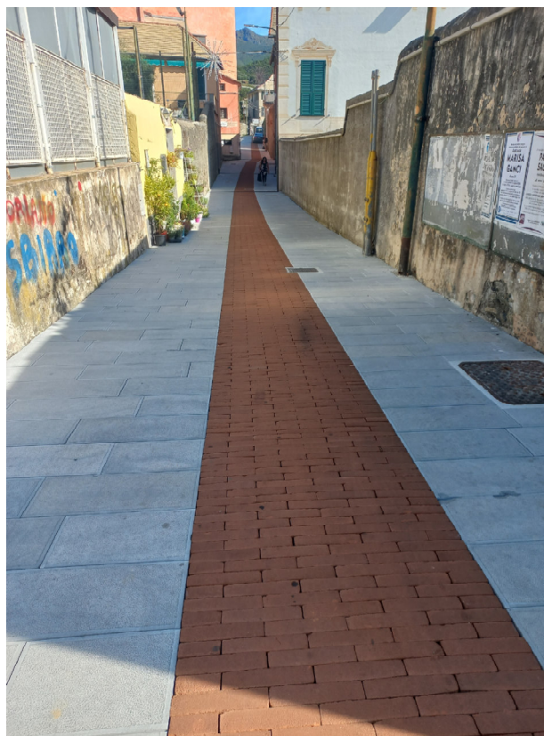
Via N.S. Assunta Post intervento
