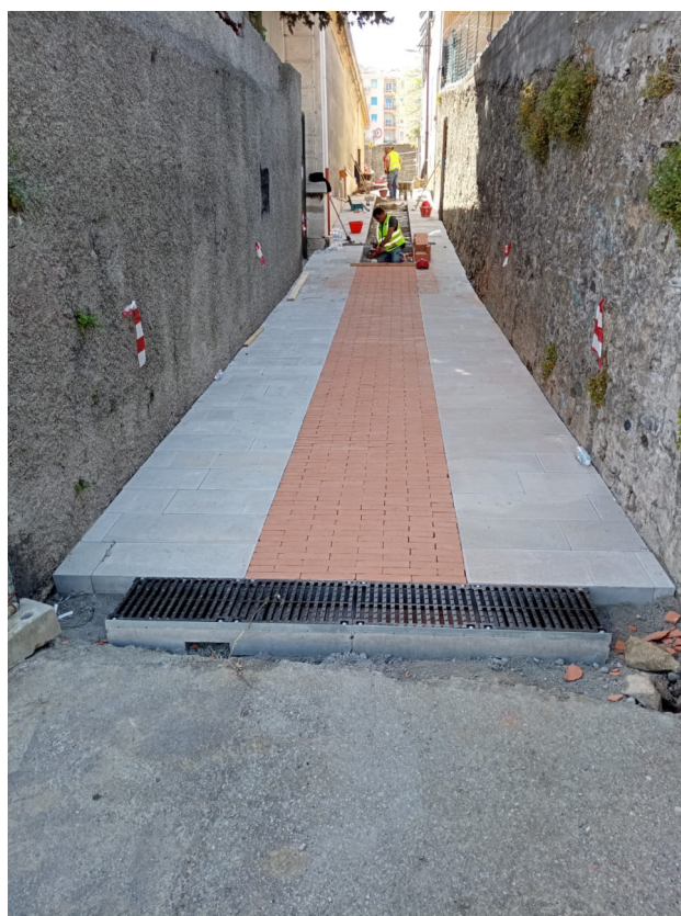
Via S.S. Trinità Intervento in lavorazione
