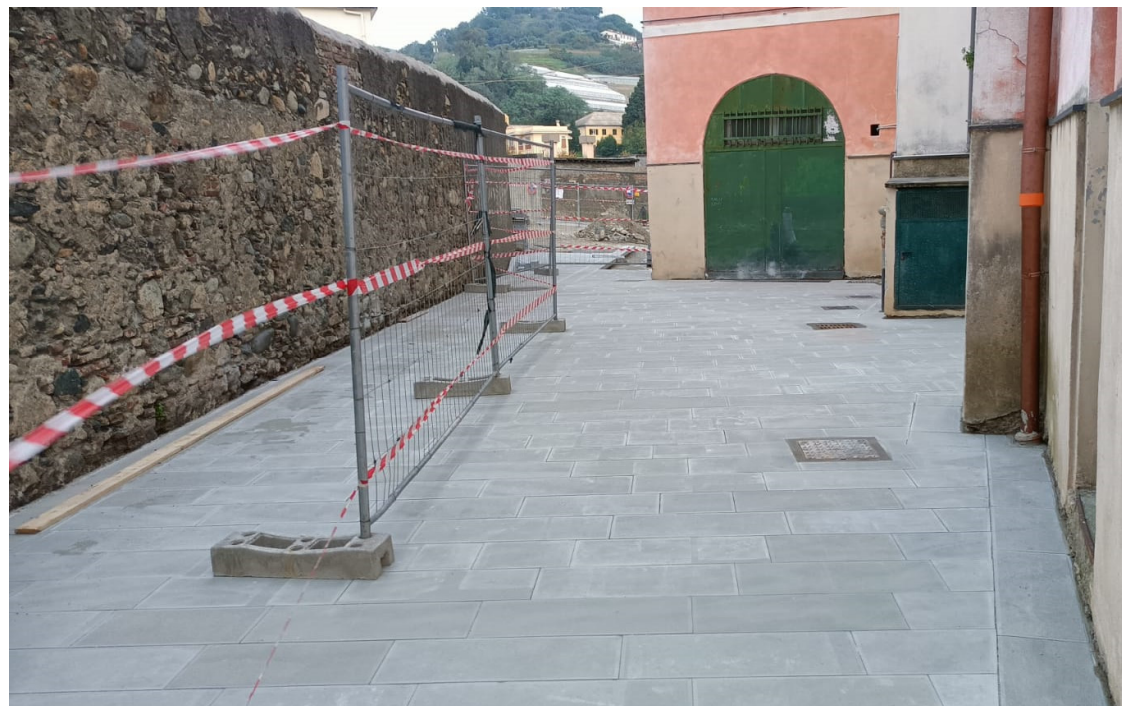
Piazza Palmaro – lavorazioni in corso
