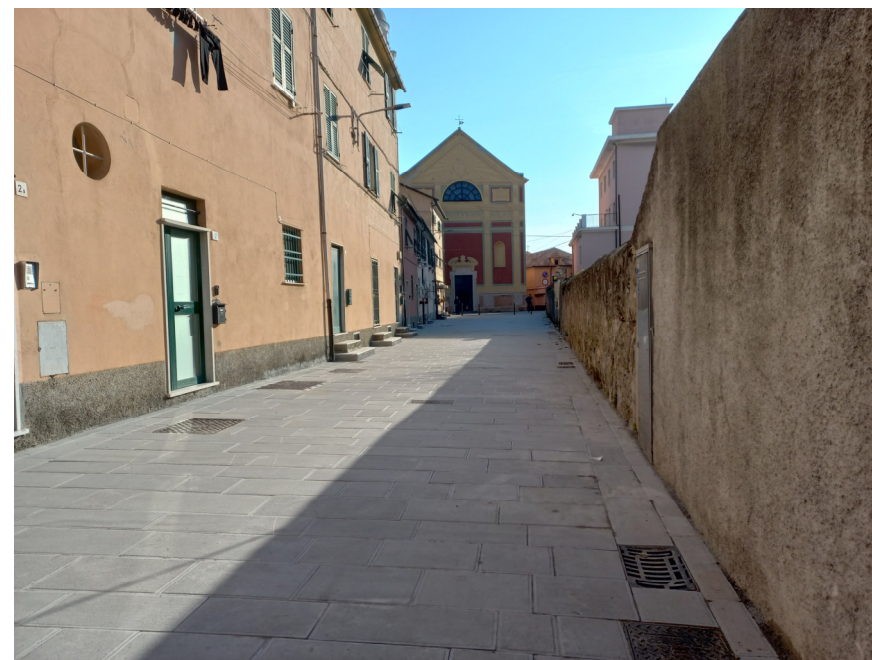
Via N.S.Assunta Post intervento
