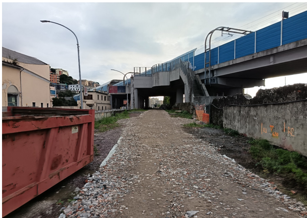
Rampa lato ponente, pista con frantumato di cava
