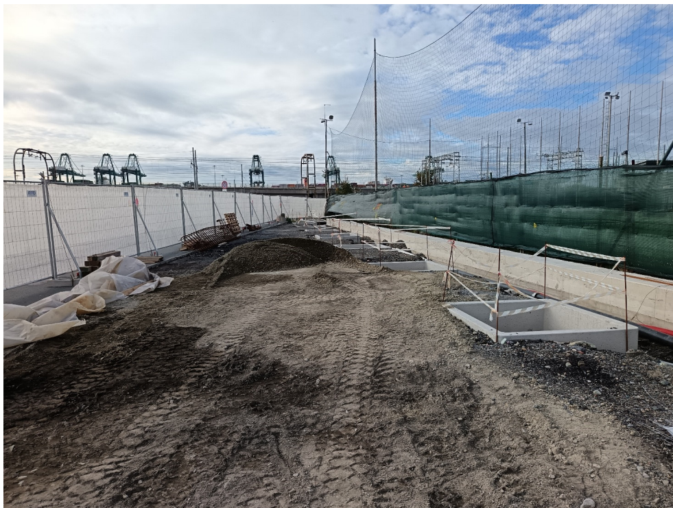
Lato campo sportivo - muro di fondazione e alloggi per palme
