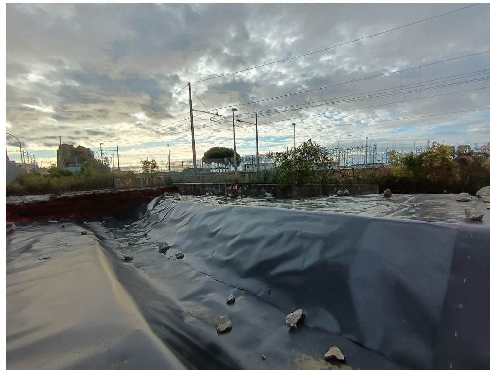
Scorcio verso levante. Scavo muro di fondazione completo)
